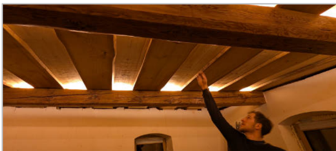
DOKONČENÝ PŘEKLÁDANÝ STROP S NEPŘÍMÝM OSVĚTLENÍM
