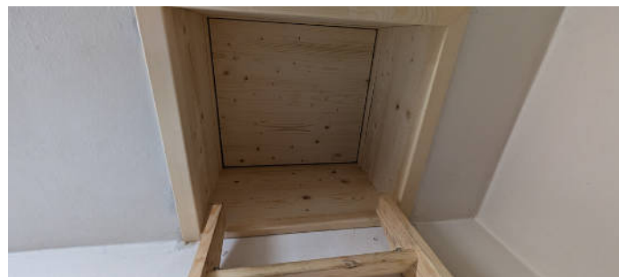
ZATEPLENÝ A ZATĚSNĚNÝ VÝLEZ NA PŮDU
