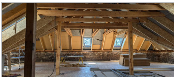
MONTÁŽ DŘEVOVLÁKNITÝCH DESEK MEZI KROKVE
